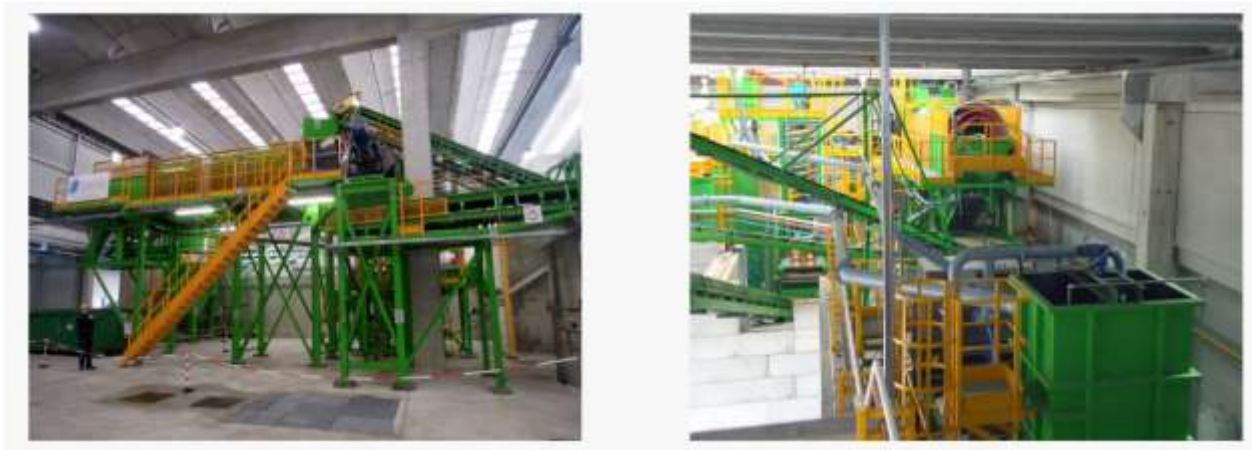
Fig.6.3: impianto di trattamento terre da spazzamento
